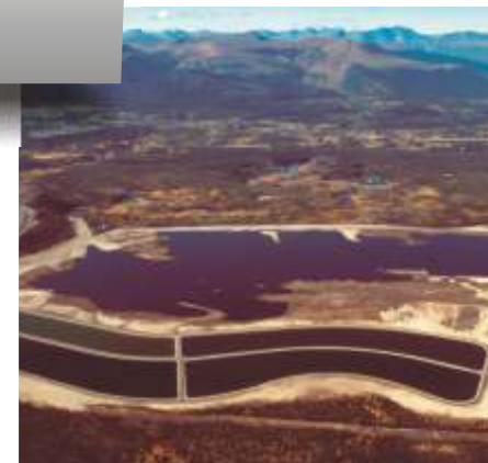
Bassins de traitement des eaux usées et étang où l'eau repose pendant un an, à la station de traitement de Livingstone Trail.
